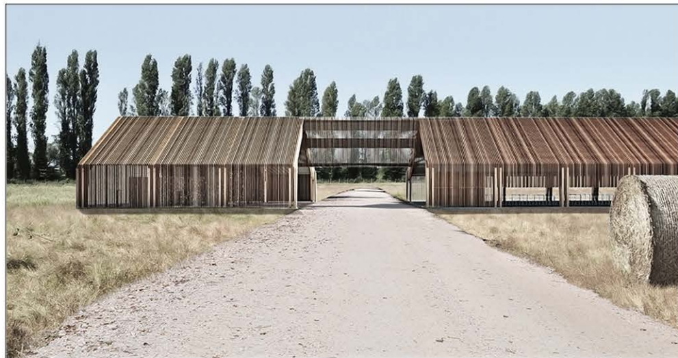
VISTA LATO NORD
